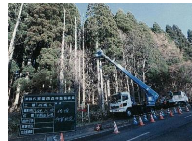
(スギ人工林伐採作業の状況)
