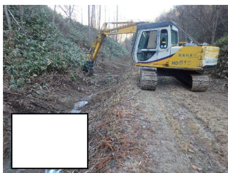
（側溝の堆積土砂の除去）
