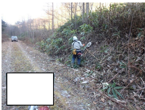
（路肩・法面伐開）
