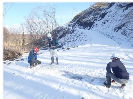
(完成：検査状況)
