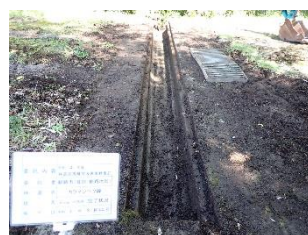
（側溝清掃状況）
