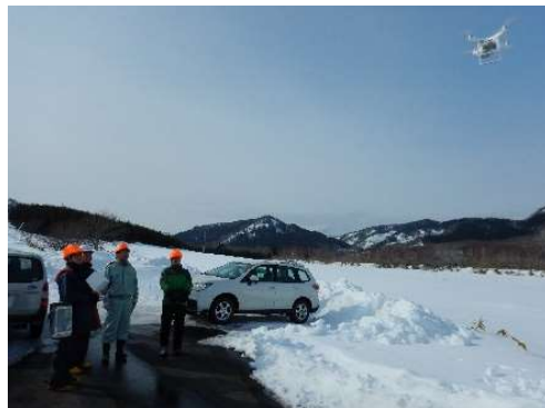
②ドローンによる現況調査
