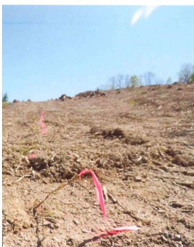
根踏み作業実施前
