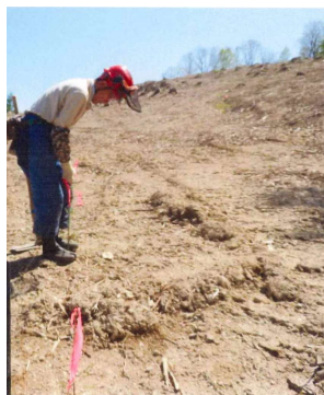
根踏み作業実施中
