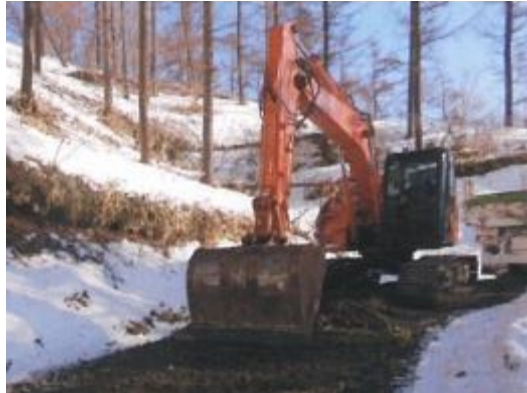
作業道補修作業
