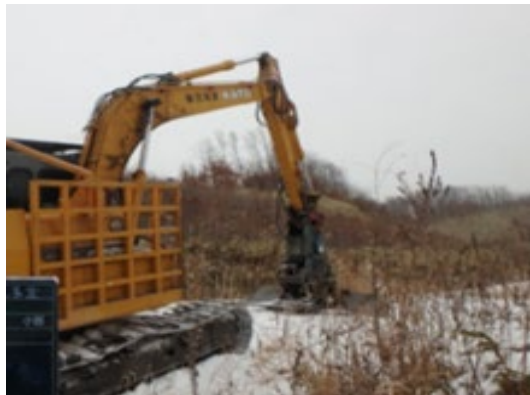
作業道補修実施状況
