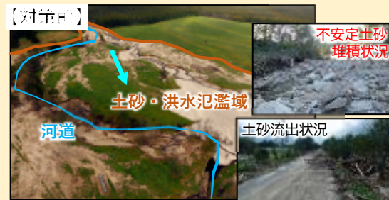
堰堤計画箇所下流の氾濫状況（H28.8）
