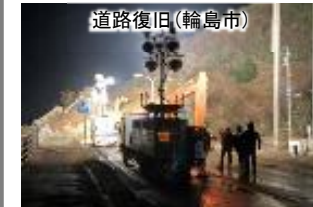
道路復旧(輪島市)
