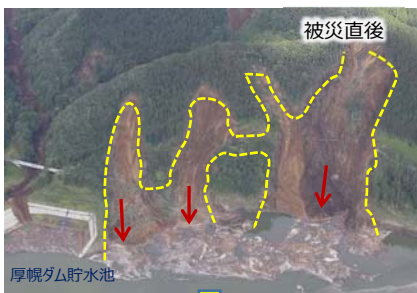
厚真川（厚幌ダム）災害復旧事業（厚真町）
