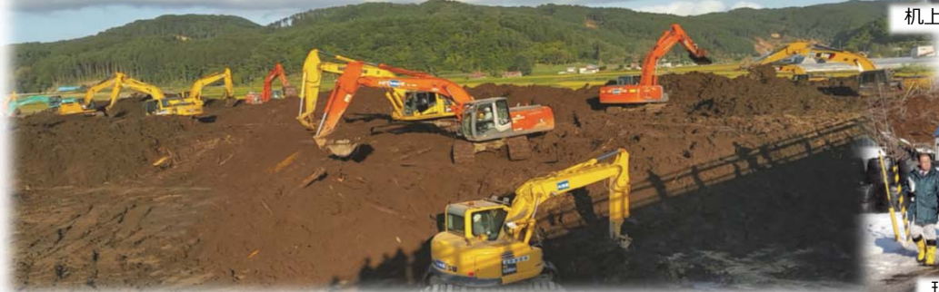
厚真川埋塞土砂除去作業（バックホウ約80台による土砂除去砂上状況）
