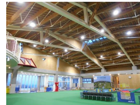
写真⑨ 照明施設のLED化 （噴火湾パノラマパーク〈八雲町〉）
