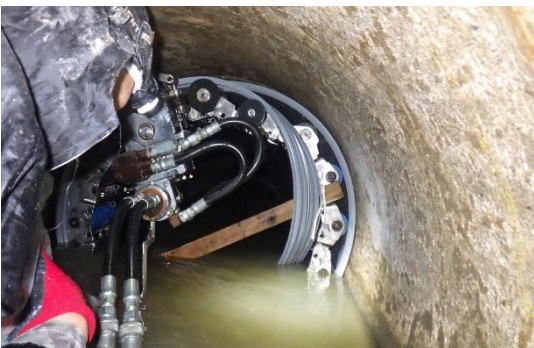
写真② 下水道管渠施設の改築状況（十勝川流域下水道〈帯広市〉）
