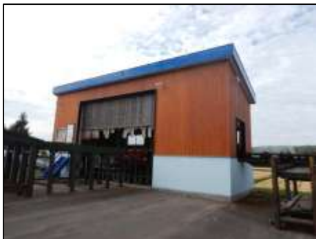
写真③ パーカー小屋修繕工事 (林産試験場 旭川市)
