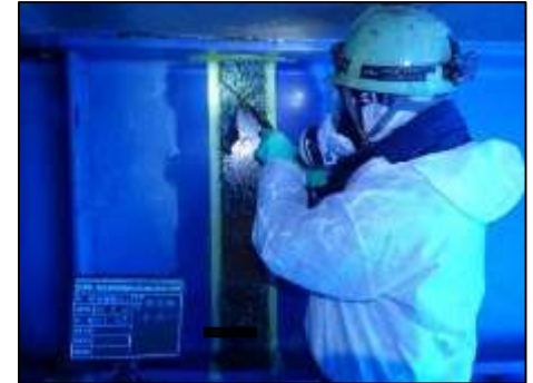
写真④ 塗膜除去工事 (パンケ橋 大樹町)
