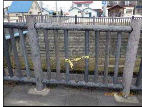
写真① 破損箇所の応急措置を実施 (美深川 美深町)
