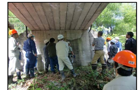
民有林林道橋梁点検技術研修会 (新十津川町 H29.8)
