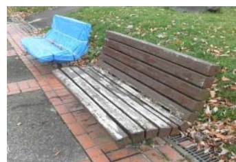
ベンチの老朽化状況
