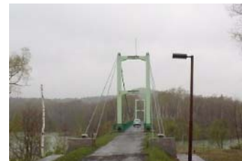
橋梁 (青山ダム地区 もりりん橋)
