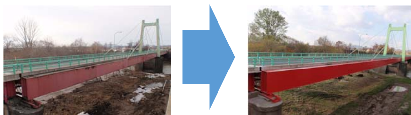
橋梁桁の補修状況(塗装塗替え)
