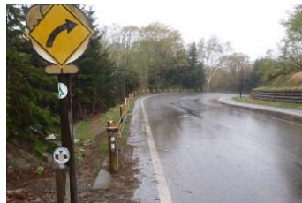
道路・付帯施設等 (神居尻地区)
