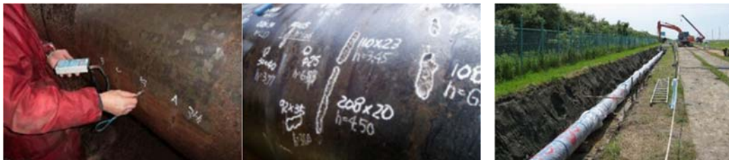
配水管の老朽診断状況
