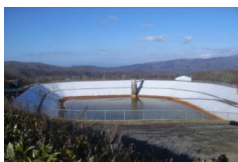
沈殿池(幌別硫黄鉱山)
