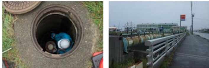
配水管の点検
