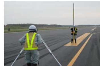
路面性状調査(測量)状況
