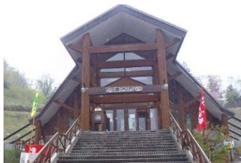
建物・小屋等 (神居尻地区 多目的管理棟)
