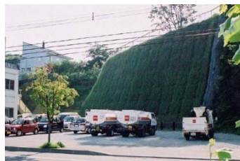
急傾斜地崩壊防止施設 法枠工 (室蘭海岸地区、室蘭市)
