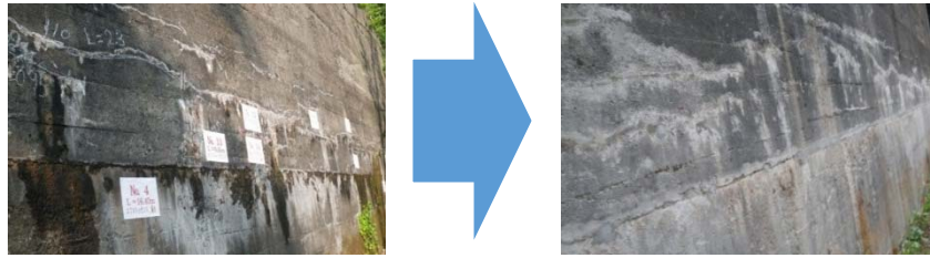
砂防えん堤の漏水対策(注入工)
