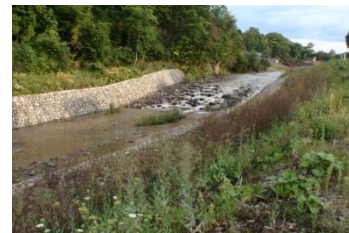
床止め(真駒内川)
