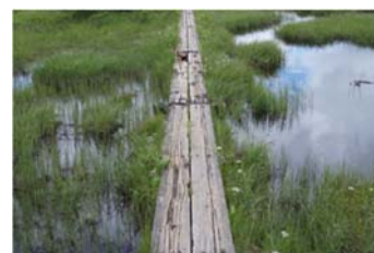
木道の老朽化状況
