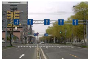
大型道路標識(オーバーヘッド)
