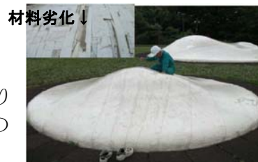
遊戯施設の点検状況
