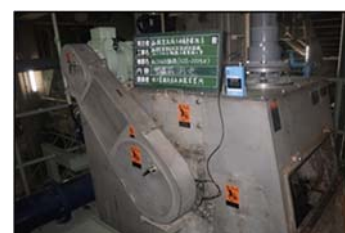
スカム分離器点検状況
