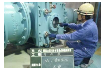
排水機場排水ポンプの点検状況
