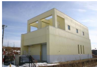
中継ポンプ場
