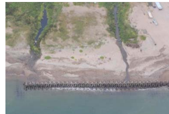
離岸堤 (忠類港海岸(標津町))
