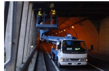
シェッド点検状況
