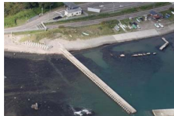
突堤 (堀株港海岸(泊村))
