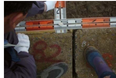
海岸護岸のクラック点検状況
