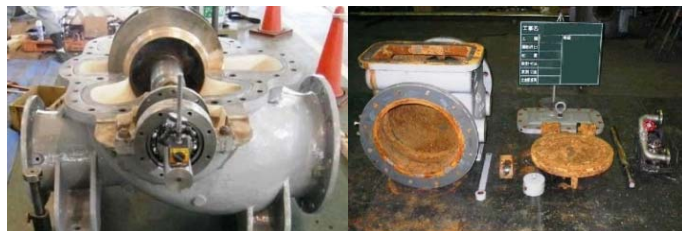
ポンプ設備の分解補修
