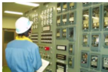
巡視点検(制御装置)
