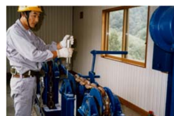
ゲート長休止装置の点検状況
