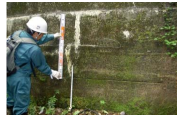
砂防えん堤のクラック点検状況
