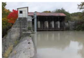
ダム[堰及び取水口]・貯水池 (滝の上発電所)
