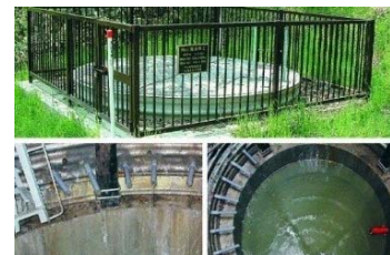
地すべり対策施設 集水井工 (桜木(2)地区、赤平町)
