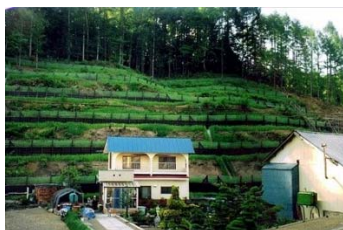
急傾斜地崩壊防止施設 柵工 (歌志内本町2地区、歌志内市)
