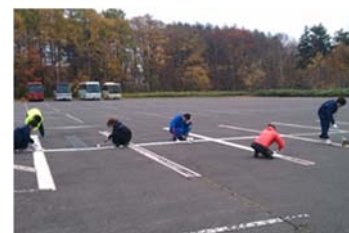
職員研修 (駐車場白線補修)
