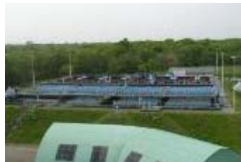
浄水場 (苫小牧地区工業用水道)
