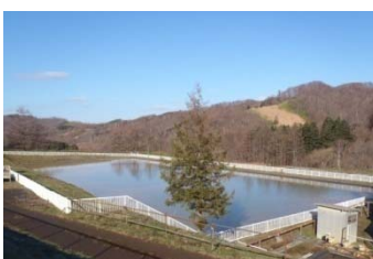
沈殿池(伊達鉱山)
