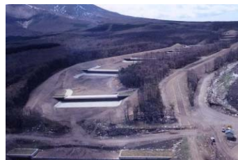
床固工群 (砂原押出沢川、森町)
