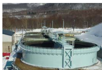
沈降分離槽(幌別硫黄鉱山)
