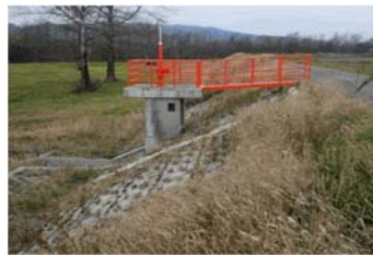
樋門・樋管(徳富川)
