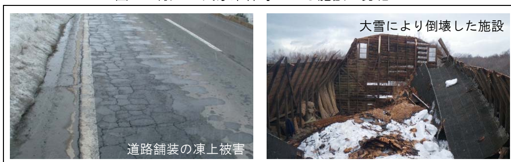
図5 厳しい気象条件等による施設の劣化
