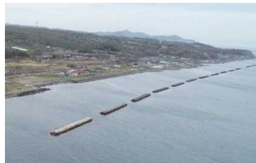
離岸堤(伊達市)
