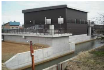
排水機場(余市川)
