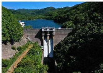
矢別ダム(函館市)
