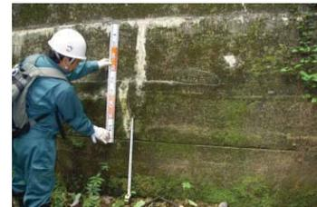
砂防堰堤のクラック点検状況
