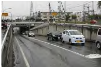
大型カルバート (美唄達布岩見沢線西10丁目立体交差)
