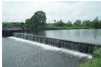
取水施設 (苫小牧地区工業用水道)
