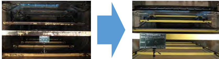
最終沈殿池汚泥掻寄機 補修状況
