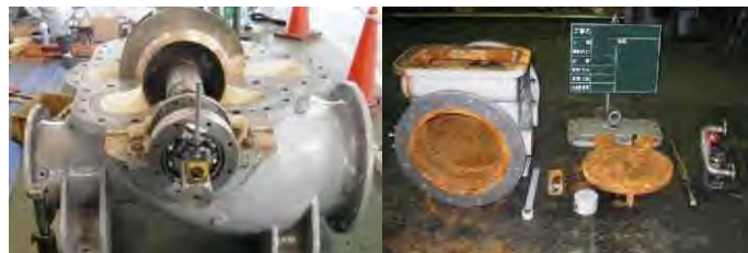
ポンプ設備の分解補修
