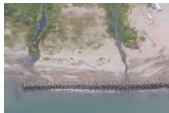
離岸堤 (忠類港海岸(標津町))
