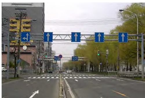
大型道路標識(オーバーヘッド)
