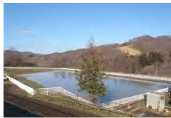
沈殿池(伊達鉱山)
