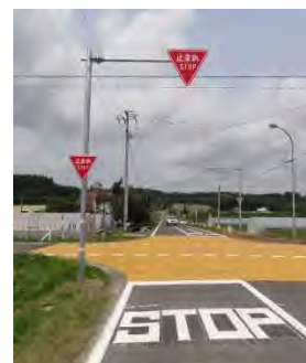
大型道路標識 (オーバーハング)
