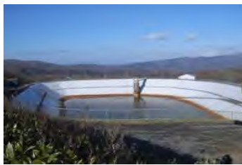
沈殿池(幌別硫黄鉱山)
