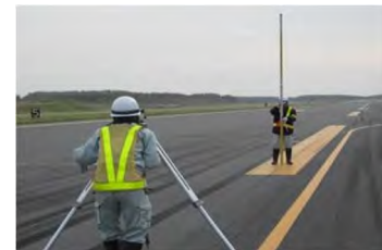
路面性状調査(測量)状況
