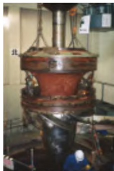
水車発電機分解点検補修
