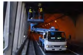
シェッド点検状況
