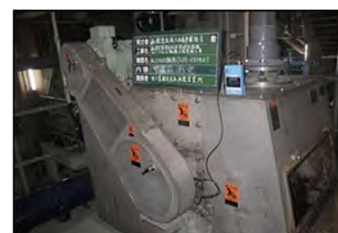
スラム分離器点検状況
