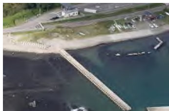
突堤 (堀株港海岸(泊村))
