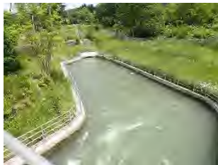
水路[沈砂池] （滝の上発電所）
