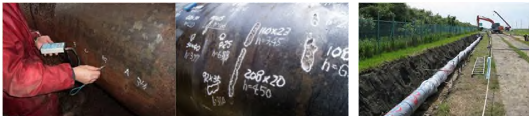
配水管の老朽診断状況
