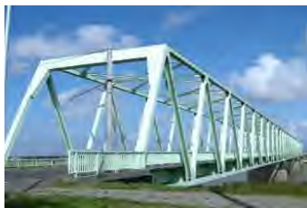
橋梁 (江別奈井江線 石狩大橋)
