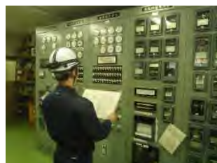
巡視点検(制御装置)
