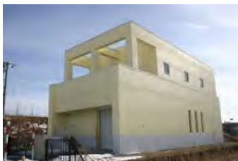
中継ポンプ場
