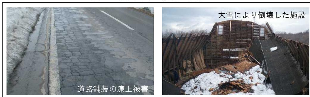
図8 厳しい気象条件等による施設の劣化
