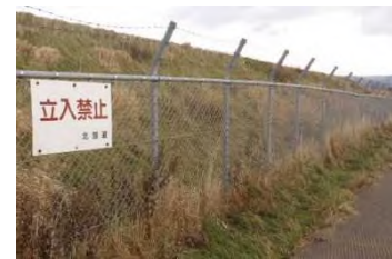
場周柵(奥尻空港)
