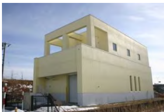
中継ポンプ場 （十勝川流域下水道）
