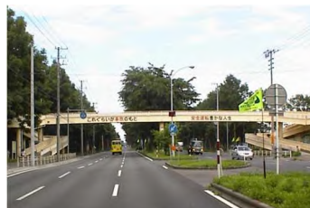
横断歩道橋 (苫小牧環状線 日新歩道橋)
