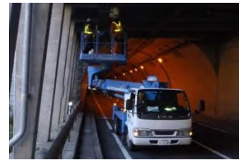
シェッド点検状況
