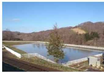
沈殿池(伊達鉱山)
