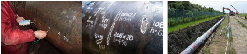
配水管の老朽診断状況
