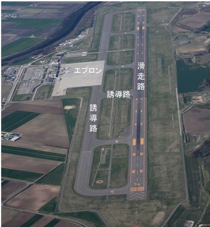
空港全景(女満別空港)
