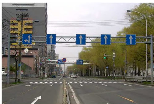
大型道路標識(オーバーヘッド)
