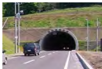
トンネル (余市赤井川線 冷水トンネル)
