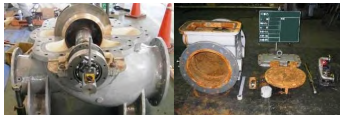
ポンプ設備の分解補修
