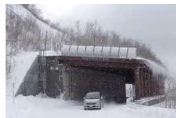
シェッド (洞爺湖登別線 オロフレ第4覆道)
