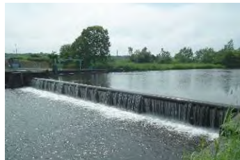
取水施設 （苫小牧地区工業用水道）
