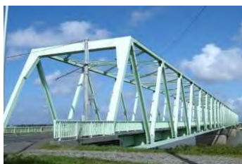
橋梁 (江別奈井江線 石狩大橋)
