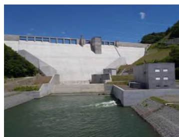
ダム・貯水池 （シューパロ発電所）
