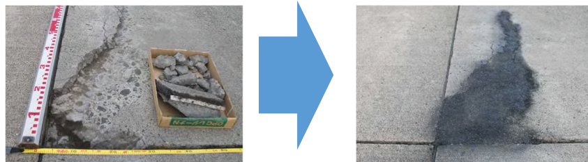
コンクリート剥離（エプロン部分）の補修状況
