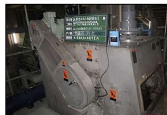
スラム分離器点検状況
