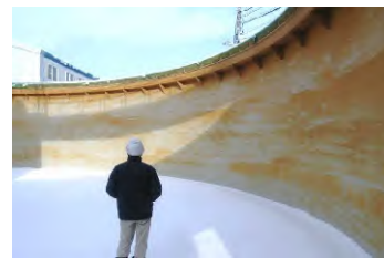
沈降分離槽の内面点検状況
