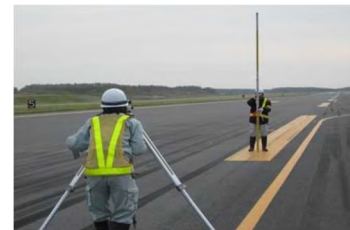
路面性状調査(測量)状況
