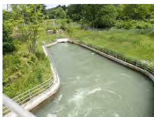
水路[沈砂池] （滝の上発電所）
