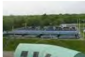
浄水場 （苫小牧地区工業用水道）
