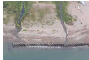
離岸堤 (忠類港海岸(標津町))
