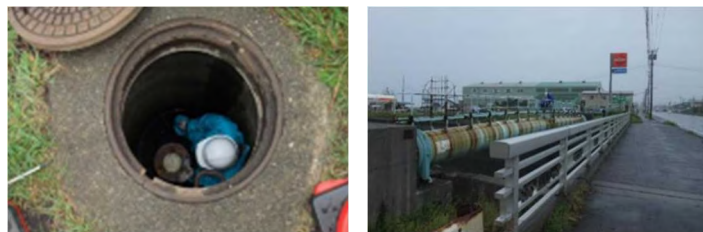
配水管の点検
