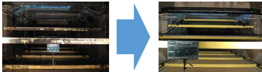
最終沈殿池汚泥掻寄機 補修状況
