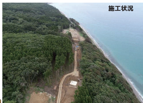
大型車はすれ違えない
