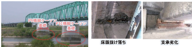
河床低下による洗掘
