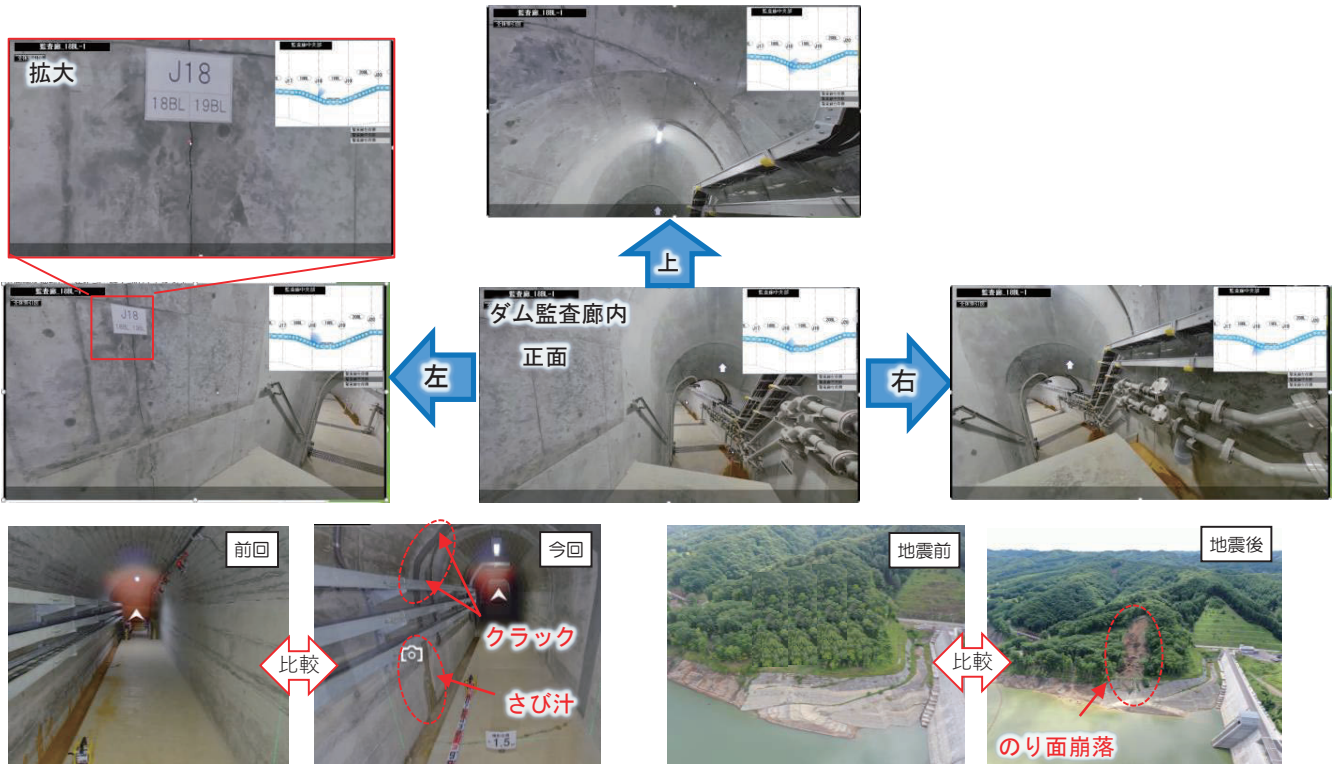
劣化の進行状況の把握
