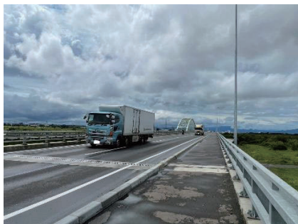
R275江別北道路4車線供用後の状況（江別市）
