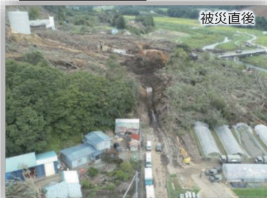
上幌内早来停車場線災害復旧事業（厚真町富里地区）
