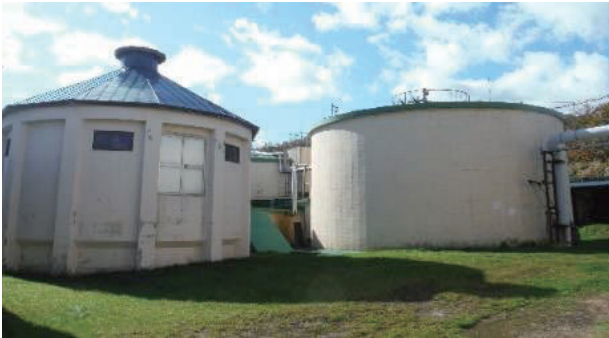
老朽化したし尿受け入れ施設の整備（余市町）
