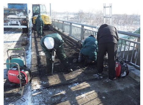
橋梁の補修状況
