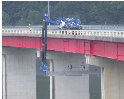
橋梁の定期点検の実施状況
