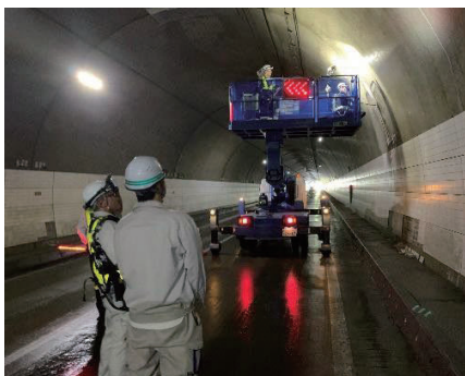
トンネルの定期点検の実施状況
