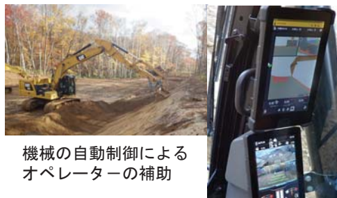
ICT建設機械（バックホウ）による掘削作業
