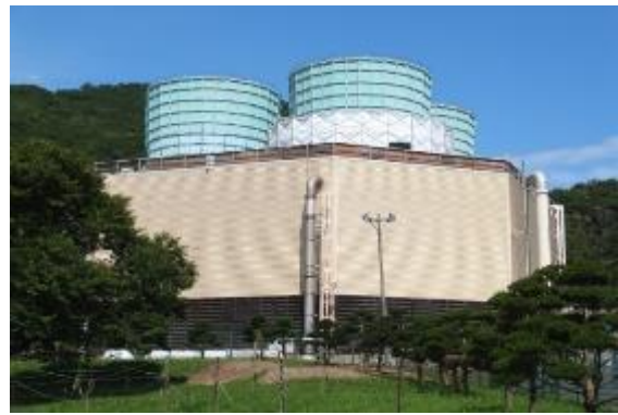
北海道電力(株) 森地熱発電所
