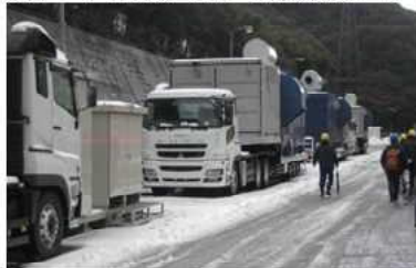
高台への電源車の配備（可搬型交流電源）
