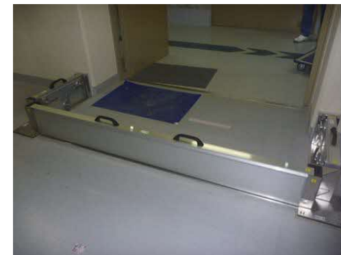
(対策例) 止水板の設置
