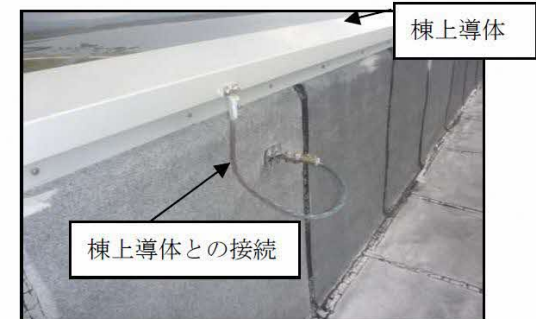
循環水ポンプ建屋
