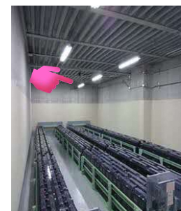
水素対策の例：水素検知器（蓄電池室）
