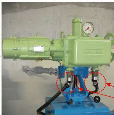
シール施工(つなぎ目からの水の流入を防ぐ)
