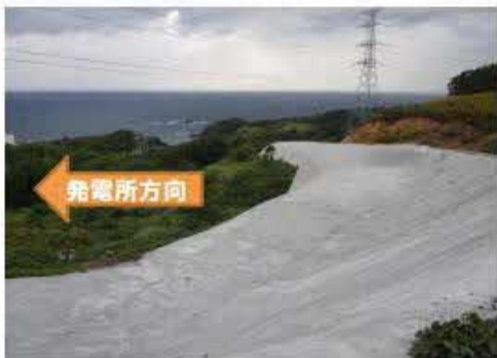
幅20mに植生防止のため モルタル吹き付け
