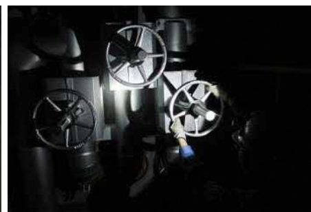
※暗所でのヘッドライト使用状況
