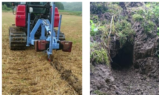
カットドレーンによる透排水性改善状況 （左：施工状況、右：施工後状況）
