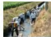
水路の泥上げ
