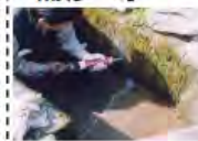
水路のひび割れ補修
