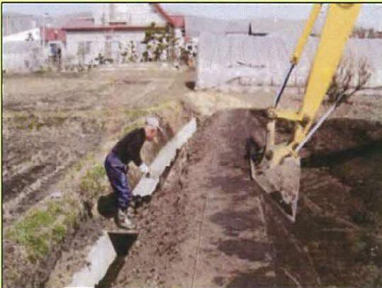
貯留機能増進のため、畦畔の再構築作業を実施している。
