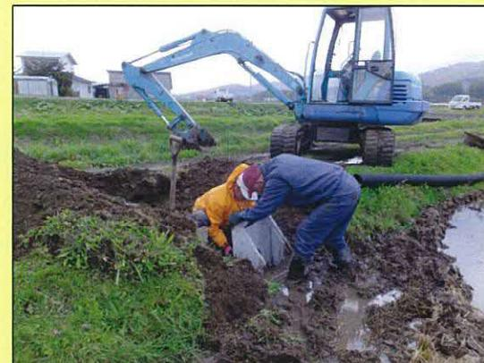
貯留機能増進のため、水位調整器具として、落口枠及び排水管の更新作業を実施している。
