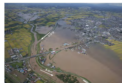
合流部での浸水状況
