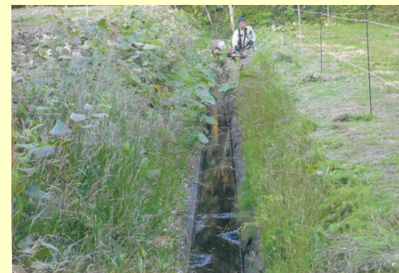
排水路草刈りの様子
