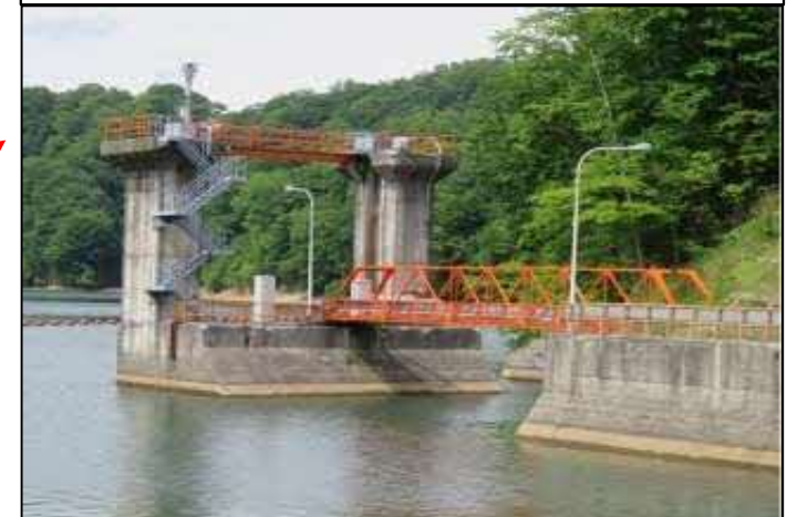
第二余水吐・連絡橋
