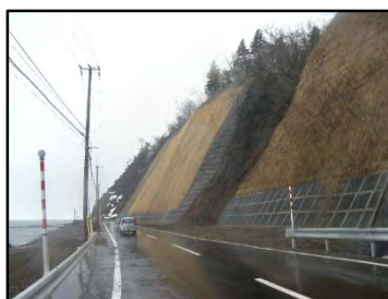
<対策例> 法枠工
