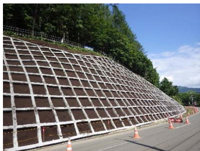
<対策例>法枠工
