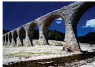
上士幌町【旧国鉄士幌線コンクリートアーチ橋梁群】
