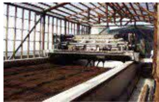
堆肥化处理施設
