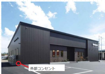
EV導入を見据え、社屋に外部 コンセントを設置<宣誓項目(8)>
