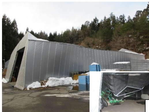
大雪により軽量鉄骨ハウスに被害(加美町)
