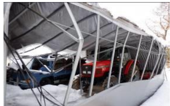
雪の重みでパイプハウスが倒壊し機械が多数破損(平泉町)
