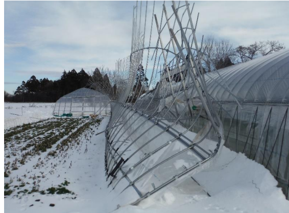
暴風雪によるパイプハウスの損壊(能代市)
