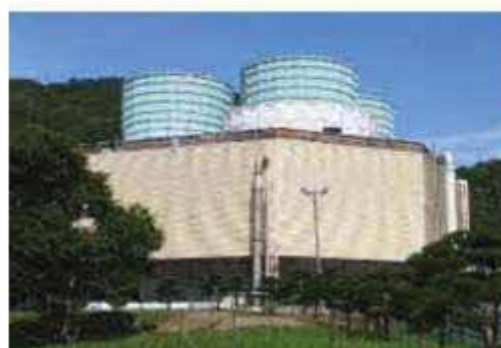
北海道電力(株) 森地熱発電所
