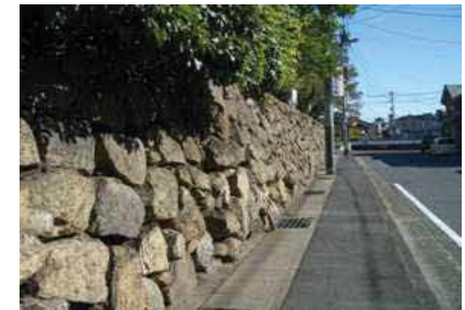
津山城宮川門跡石垣(津山市)
