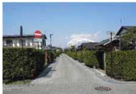
仲町伝統的建造物群保存地区内の無電柱化 & 消雪側溝整備 (青森県弘前市)
