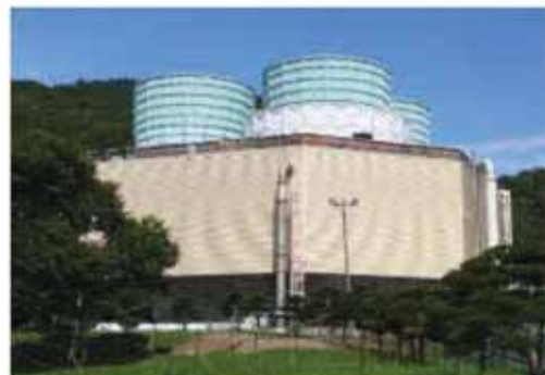
北海道電力(株) 森地熱発電所
