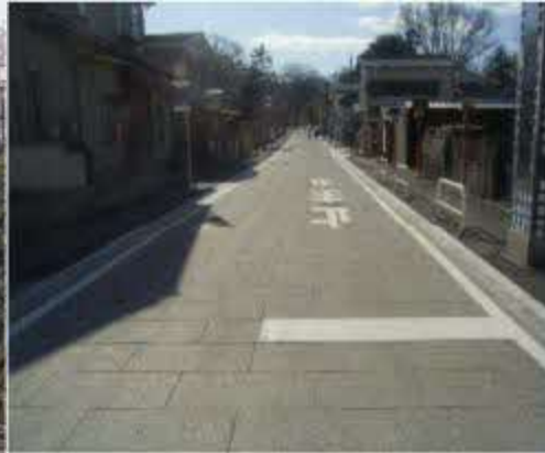
道路の美装化・無電柱化
