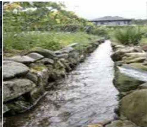
灌漑用水石積改修工事
