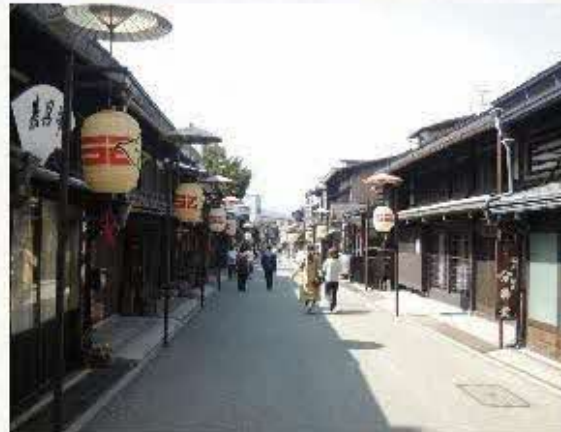
無電柱化した下二之町大新町地区
